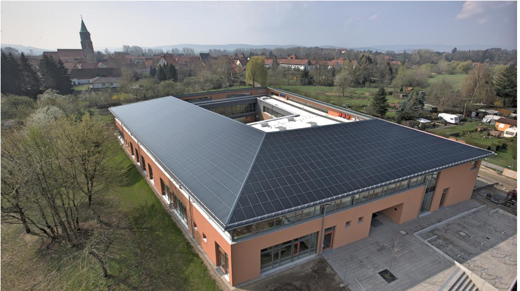
Schule Gronau PV-Anlage
