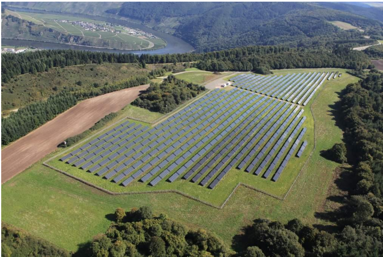
Solarpark Mehring © juwi.de
