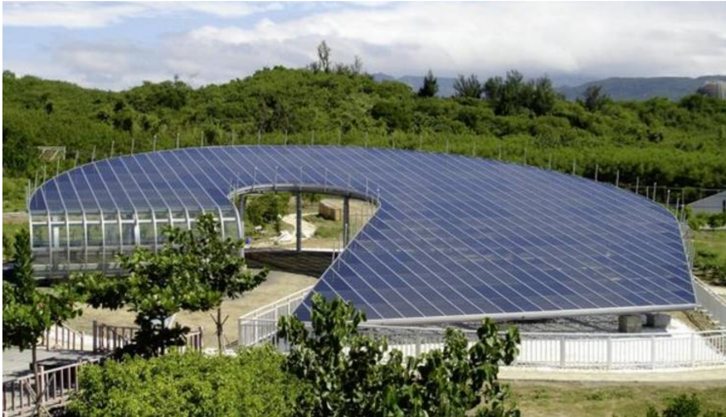
Das mit 50 Kilowatt Nennleistung bislang größte BIPV-Projekt Taiwans, Crystal Garden © Abakus Solar AG
