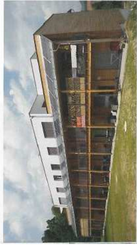
Der Wohnbau – Massiv- und Holzbau zu Passivhaus kombiniert
